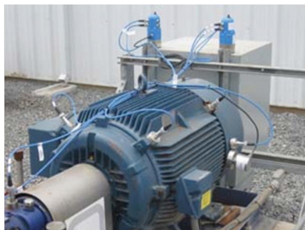
Рисунок 3-5 | Система контроля двигателя на базе накопления энергии вибрации [14]
